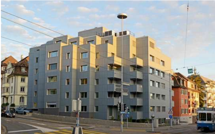
Gebäude in Zürich von Viridien Architekten mit grauen Solarmodulen als Fassade von Sonnenkraft
