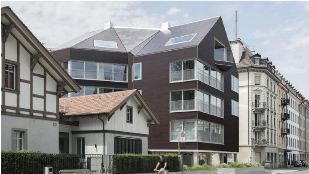
Projekt Solaris in Zürich: preisgekröntes Gebäude mit Solarmodulen als Fassadenverkleidung rundherum
