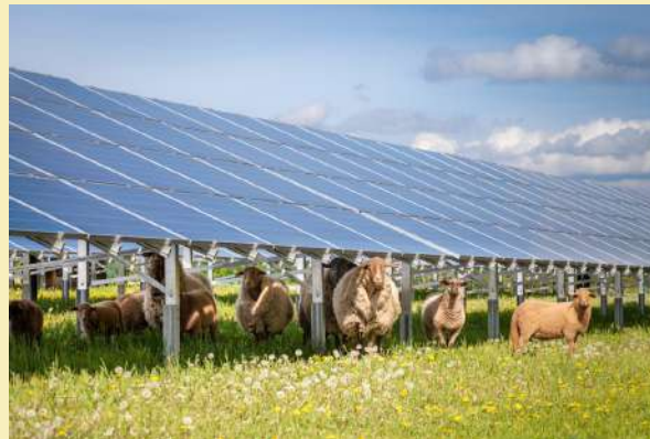
Erweiterung PV-Anlage Schafflerhof 5.200 kWp
