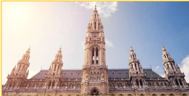
Rathaus 234 kWp -Eröffnung 12.9.
